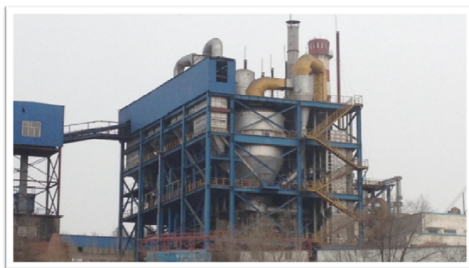
12000 \text{m}^3_{\text{N}} 煤气/小时双流化床气化示范装置
