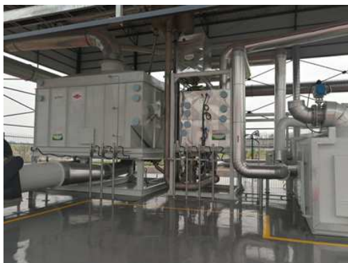
2 万 m 3 /h 的流化床吸附浓缩-催化燃烧装置适用于流化床的高耐磨性能球形吸附剂
