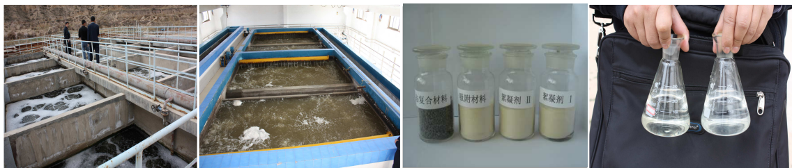
在生化处理污水前采用絮凝沉淀初级处理后, 专用絮凝剂样品 水处理后与自来水对照 图有室外(左)室内(右)曝气生化水处理情况
