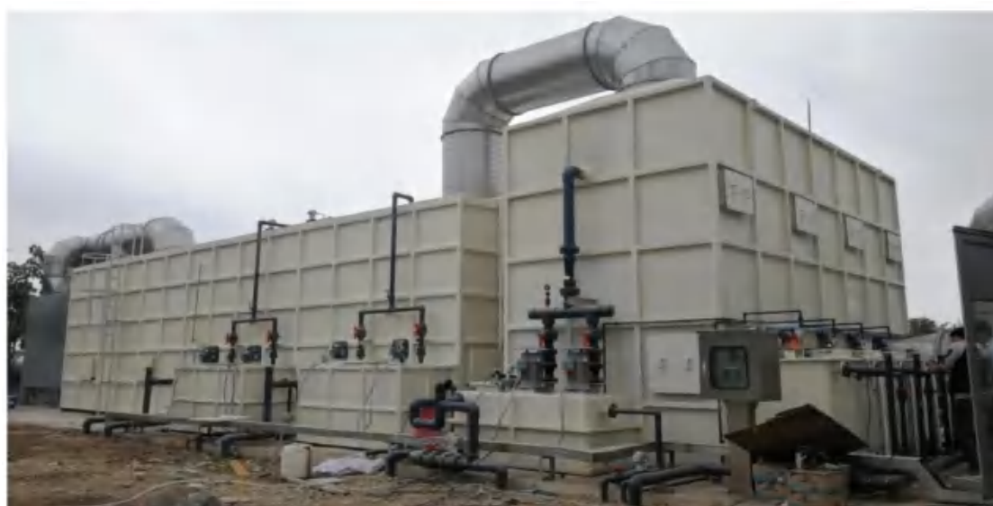
生物除臭工程应用(海南北控水务污水处理厂)
