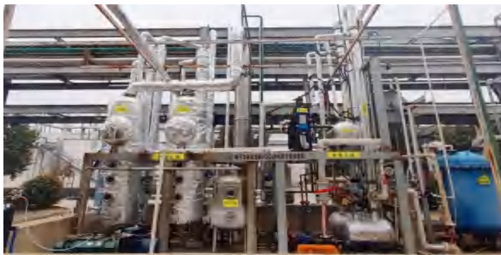
图 2 40 万 \text{Nm}^3/\text{h} 离子液体法含氯 VOCs 净化回收侧线装置
