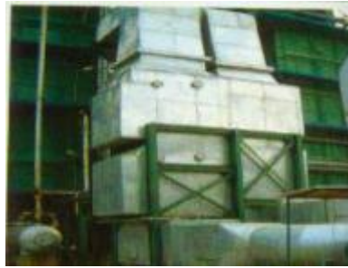
图 4.无机传热装置(卧式)
